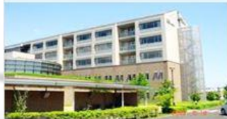
みやぎ県南中核病院 http://www.southmiyagi-mc.jp/
