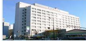
仙台市立病院 https://hospital.city.sendai.jp/
