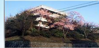
気仙沼市立病院 http://www.kesenuma-hospital.jp/
